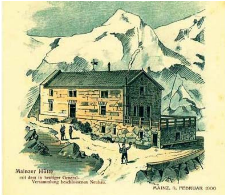
Die von der Sektion Mainz erstmals wieder aufgebaute Hütte mit Anbau (um 1900)
