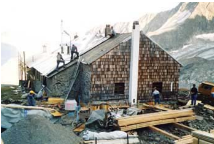
Kaunergrathütte zu Beginn des Umbaus 2003
